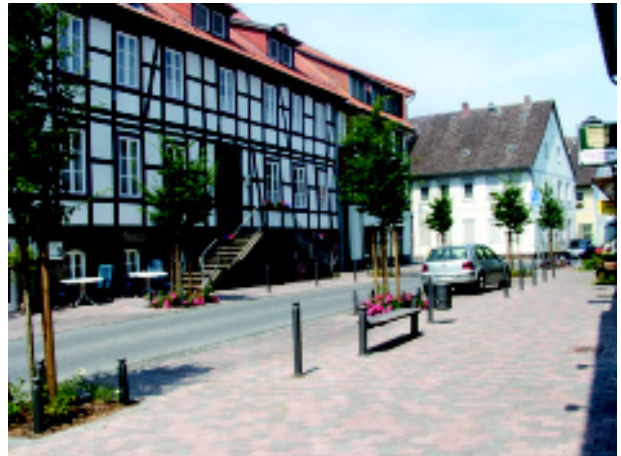
Die neu gestaltete Bahnhofstrasse in Dassel vor dem sanierten Alten Rathaus
